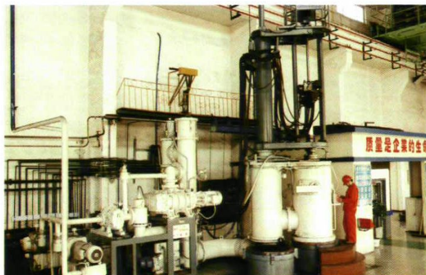
抚钢股份公司第三炼钢厂7吨自耗炉
