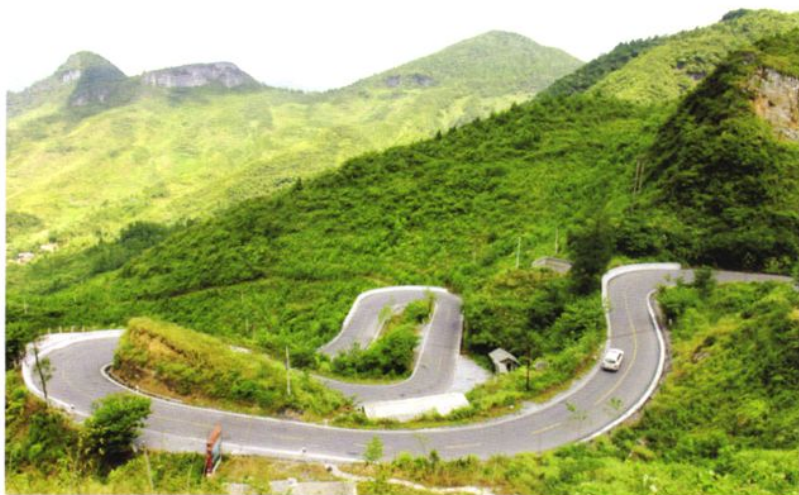
2002年，遵义市实现县县通油路，乡镇通公路。2006年，所有乡镇通油路，至2007年，全市公路通车里程达到23944千米，其中等级以上公路9043千米。图为改建后的盘山公路（图43）
