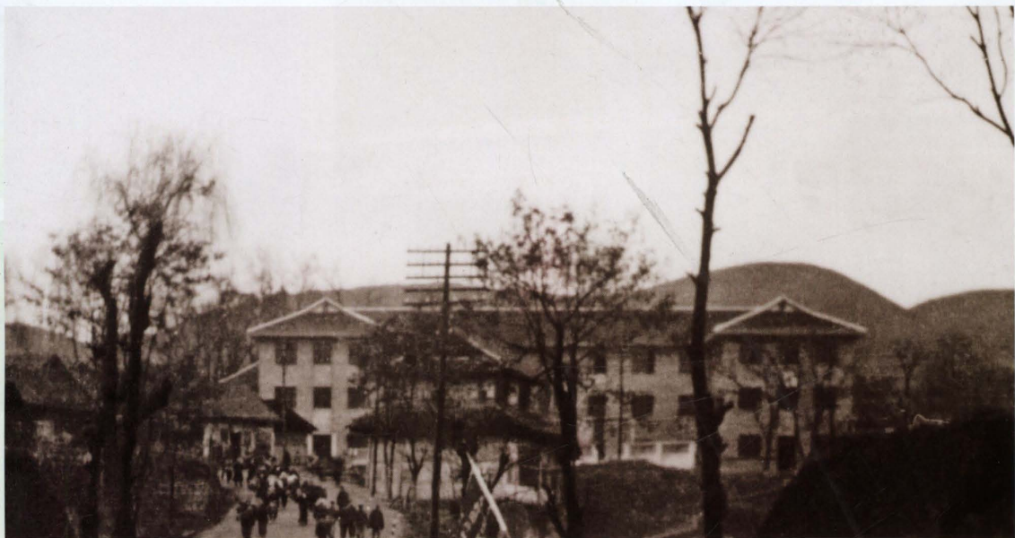
1984年12月以前使用的县人民政府办公大楼
