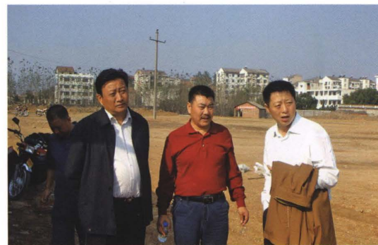
2008年10月，市委常委、副市长黄智华(右)在当阳货运站建设工地检查工作
