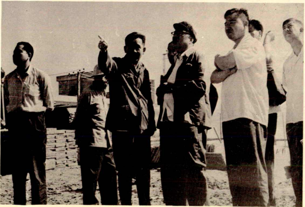
黑龙江省委第一书记杨易辰于1980年7月7日视察富拉尔基二电厂工程建设
