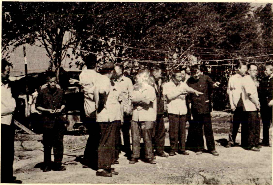
水利电力部副部长张彬于1979年8月9日视察富拉尔基二电厂工程建设
