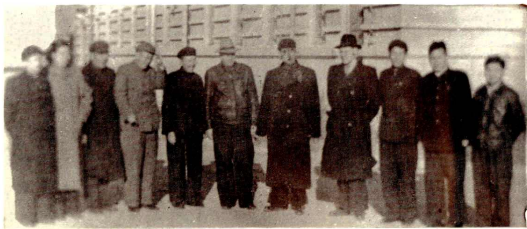
中共中央政治局委员国务院副总理薄一波于1958年2月视察富拉尔基热电厂
