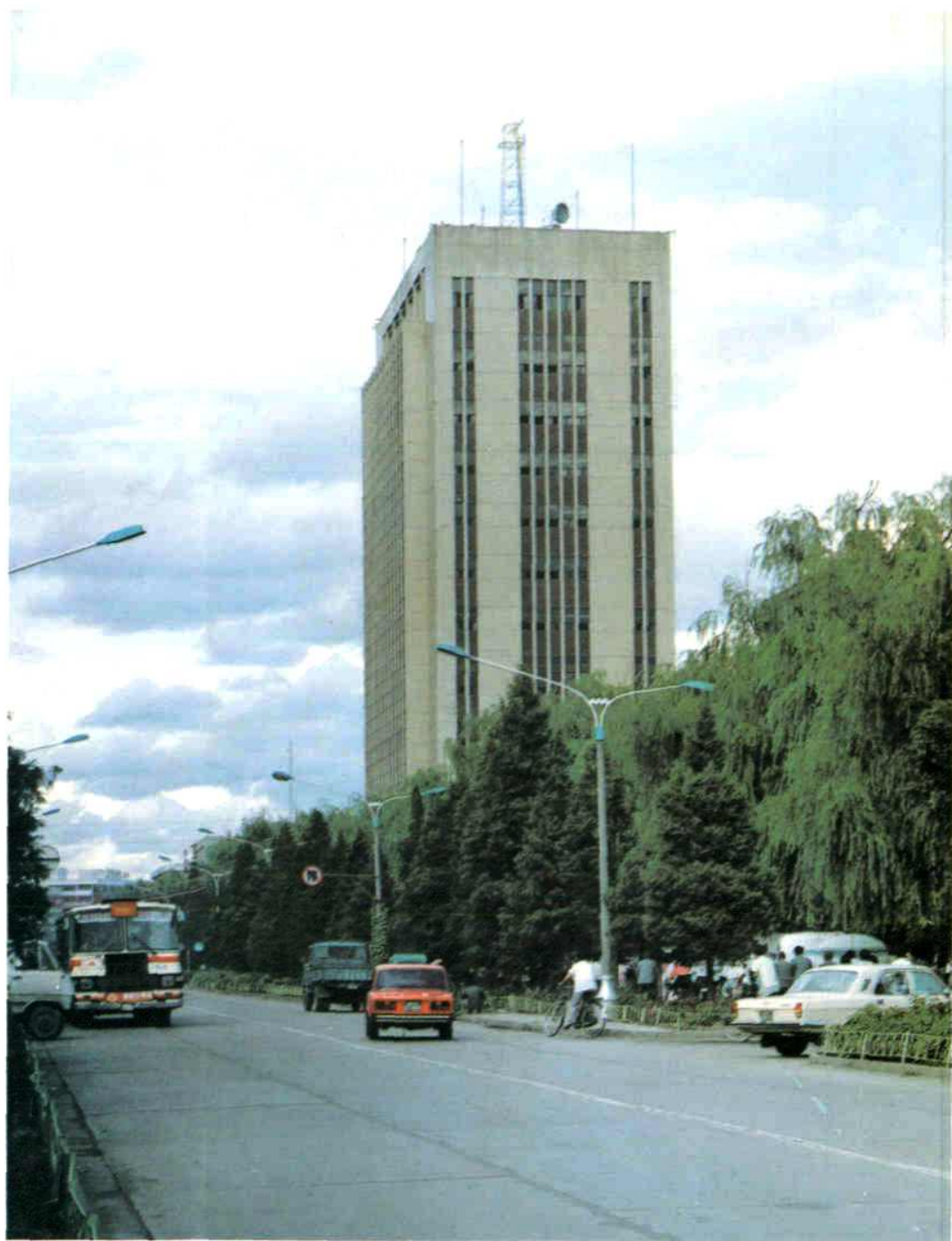
呼和浩特电信枢纽楼
