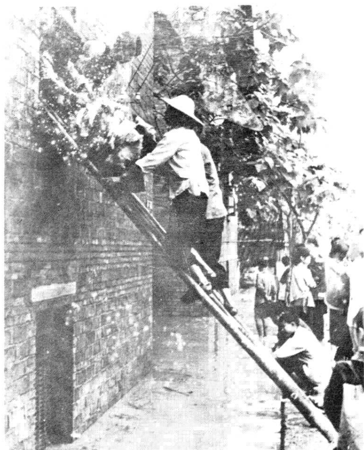
西门外居民搭梯抢险
