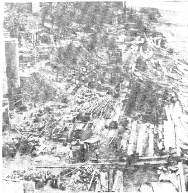
县水泥预制品公司堤崩场毁
