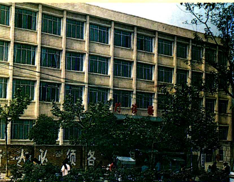
县医院门诊楼
