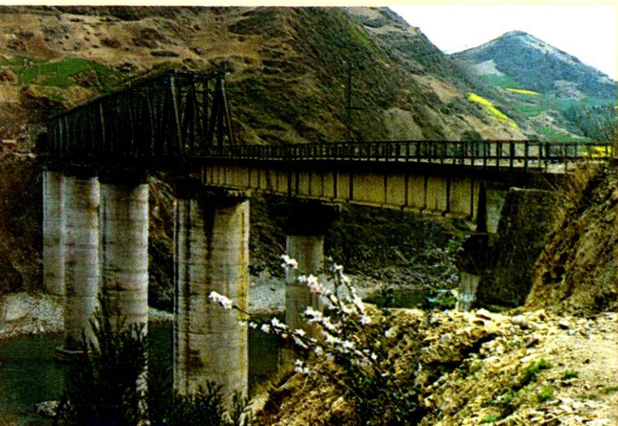
阳安铁路石泉六号桥
