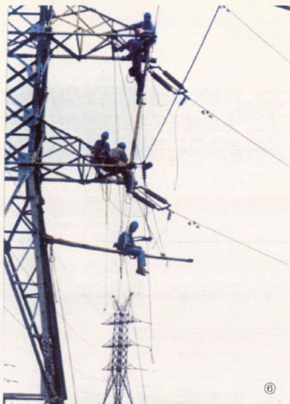
6. 2000年10月，110千伏六（合）—洪（将台）1号线施工现场
