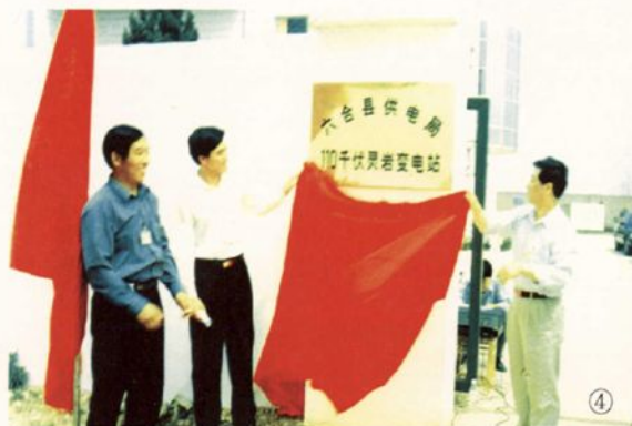
4. 1999年5月28日，六合县供电局110千伏灵岩变电站投运
