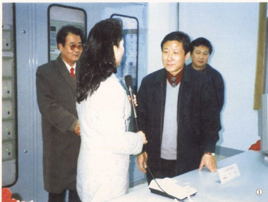
1. 1997年12月,南京市人民政府副市长奚永明(左三)视察110千伏龙池变电站
