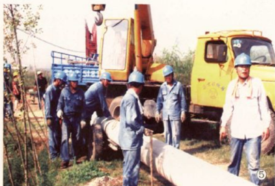
5. 1999年6月，六合县农村电网建设与改造施工现场
