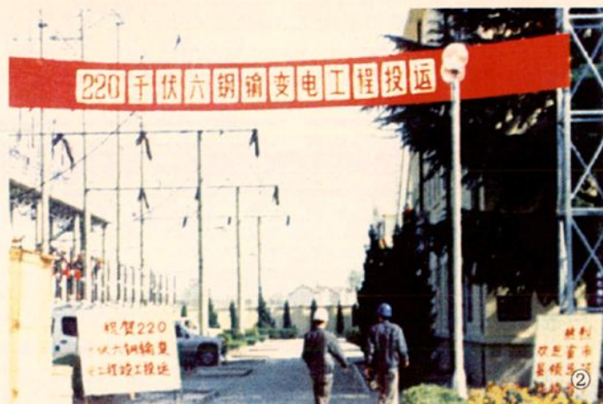
2. 1997 年 11 月，220 千伏六钢输变电工程竣工投运
