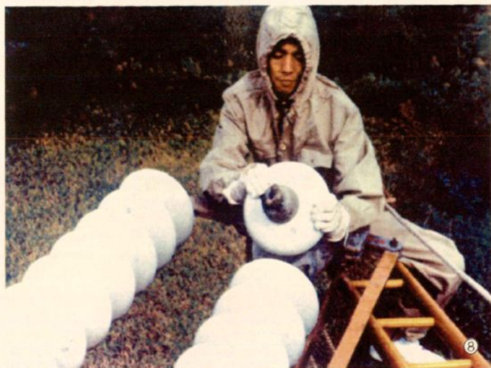
8. 220 千伏马六线带电更换绝缘子
