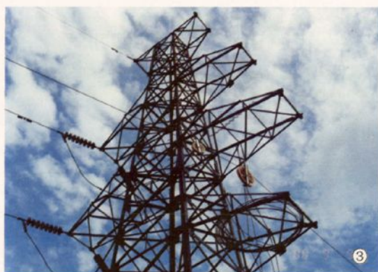
3. 2000 年 9 月，六合供电公司首次采用张力 施放通信电缆
