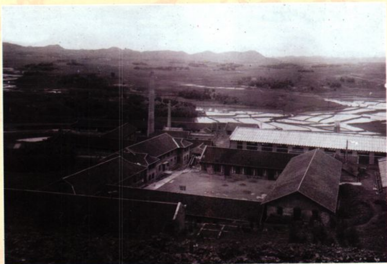
工厂(新桥)全景
