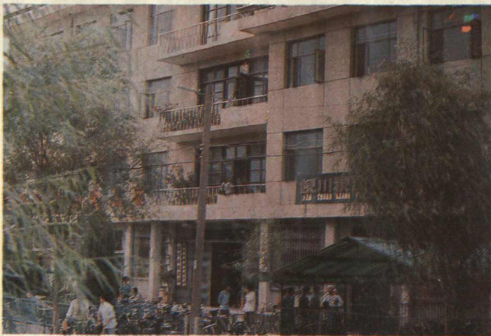
▲ 市粮食局办公楼一角
