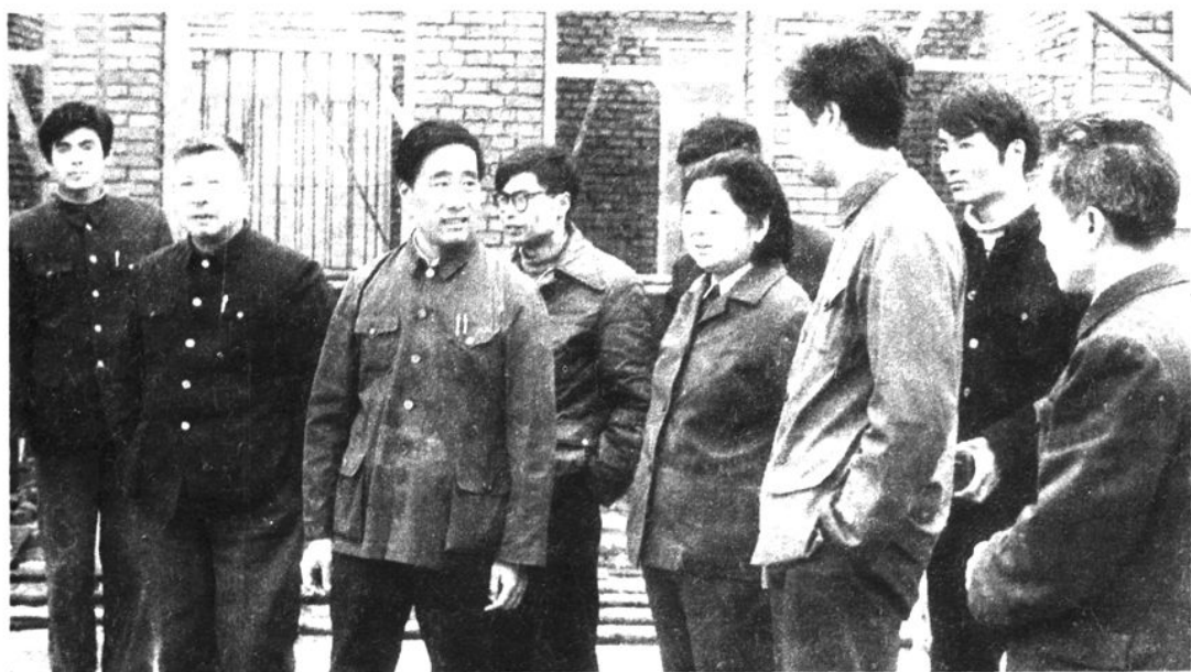
江苏省省长顾秀莲（女）在新建测试中心大楼工地
