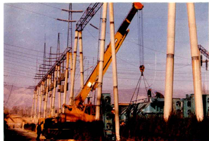
大修 220 千伏 15 万千伏·安变压器
