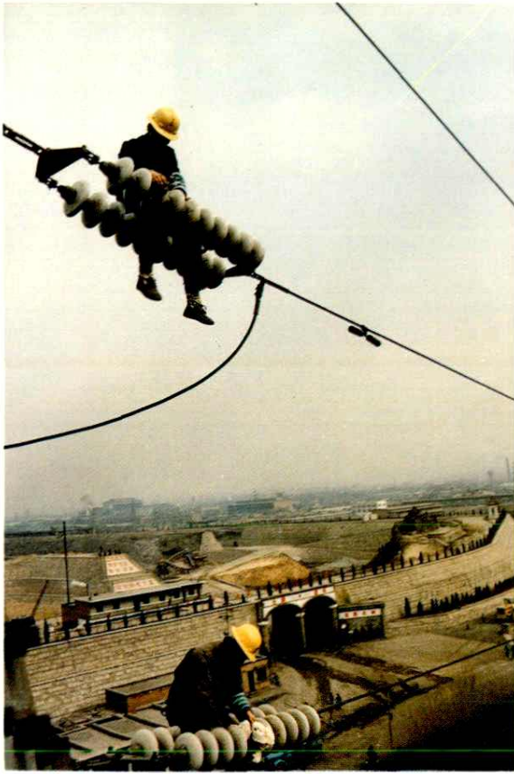
110 千伏线路带电清扫
