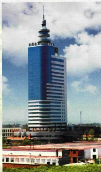
电业局电力调度中心
