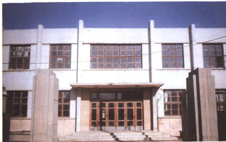
盐山县第一栋 教学楼——东关中 学教学楼(1986年建)
