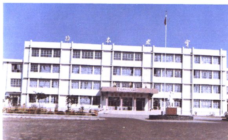
盐山中学教 学楼(1992 年建)
