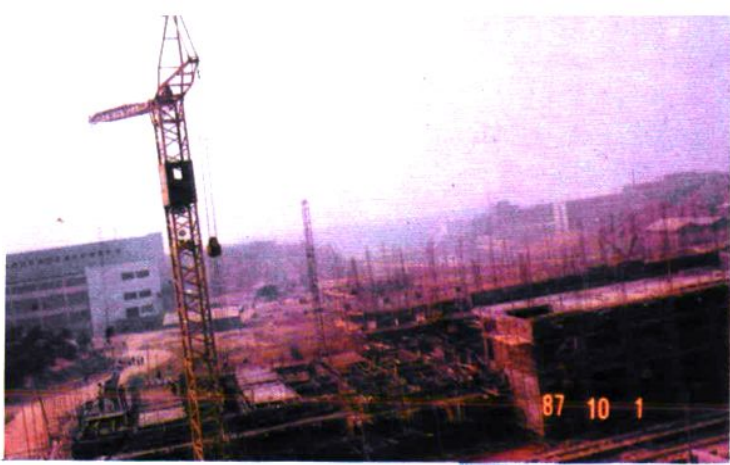
施工中的外语楼
