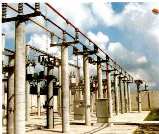
吴山变电所采用的最新铝质硬管母线
