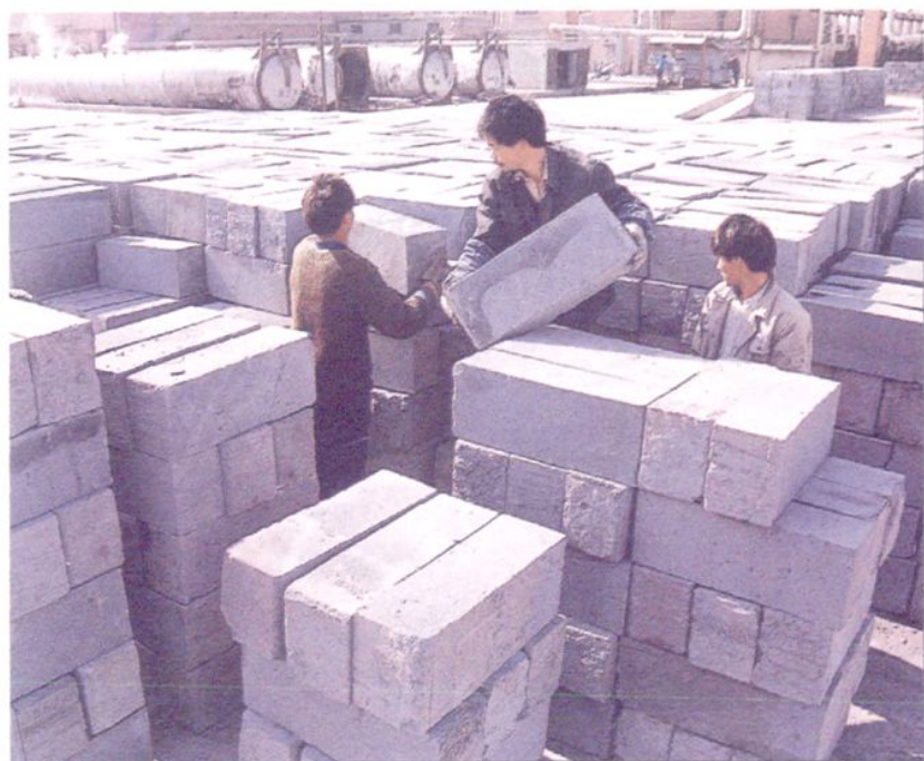
厂属淮阴市粉煤灰 开发公司“加气混凝土砌块”生产现场
