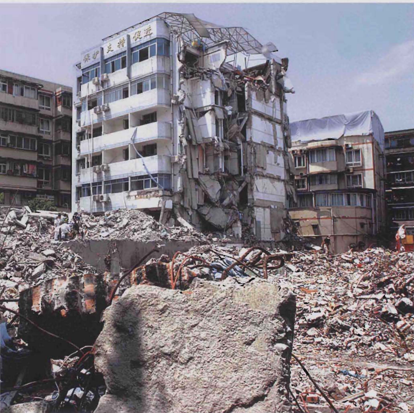
都江堰市公共建筑损毁现场
