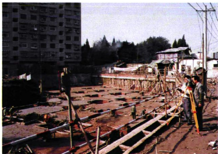
深基坑开挖监测 (1996年摄)
