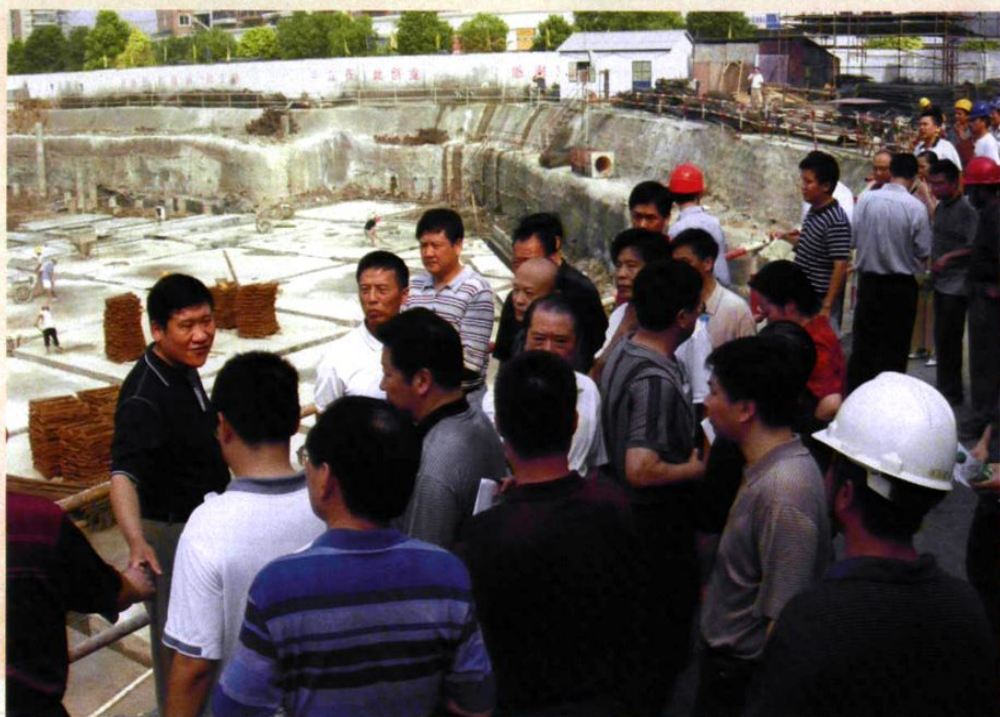
2005年武汉市市长李宪生(左1)视察勘测工地
