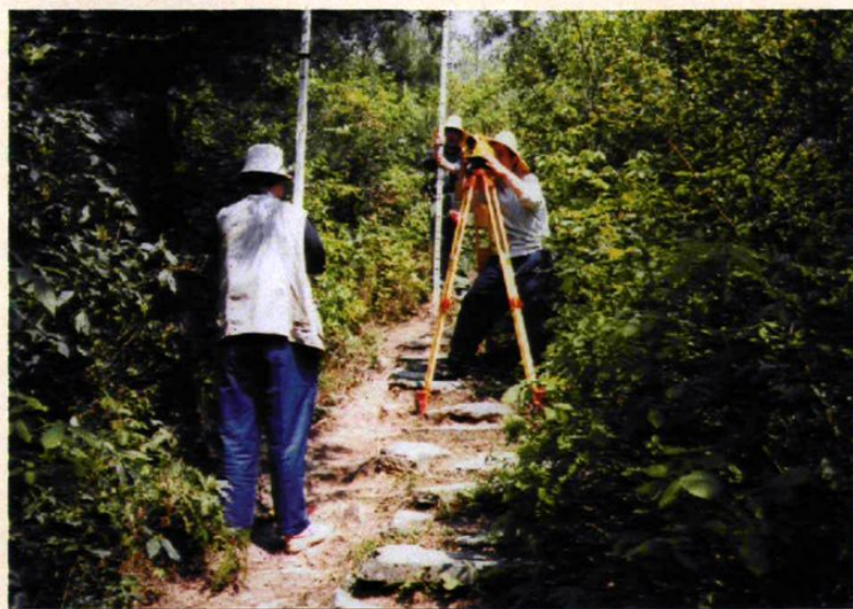
隧道測量(2002年攝)
