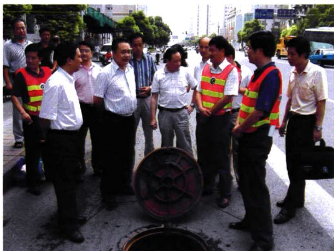
武汉市城市规划管理局局长张文彤(前排左2)深入地下管线测量工地
