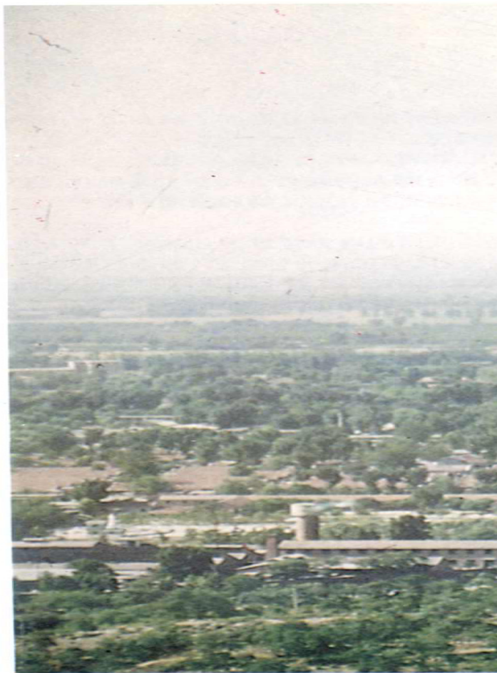
北京电力设备总厂鸟瞰
