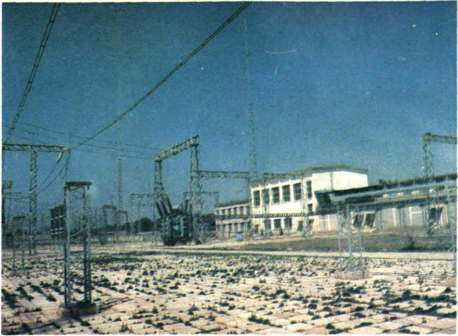
东郊变电站外景 (云致忠 摄)
