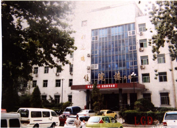
1995年建成的住院大楼，现为体检大楼
