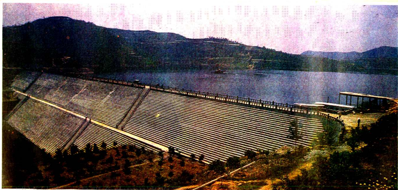
▼ 继光水库坝区
