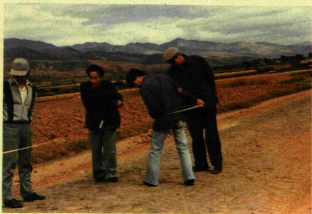
工程技术人员在关巍公路改线测设
