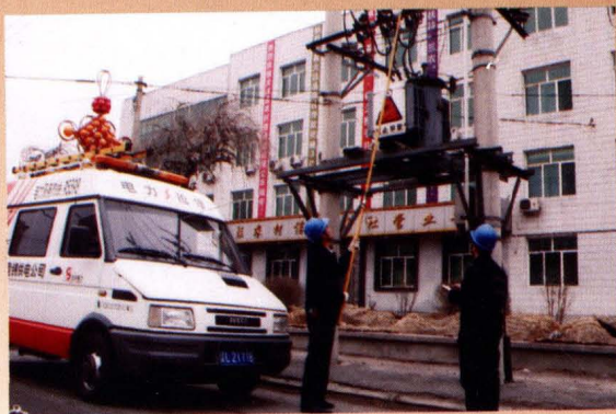
▲ 窗口单位修理人员坚持24小时维修 (2005.1.28)
