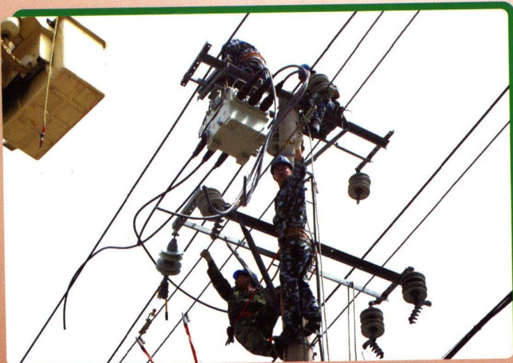
◀ 兴隆台供电分公司进行线路维修 (2007.6.6)
