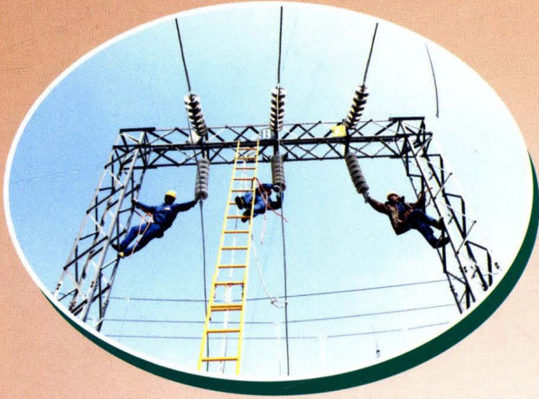
▲ 变电设备改造 (2006.3.25)
