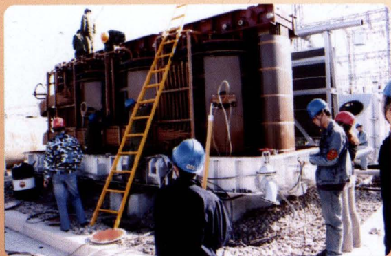
▼ 变压器吊芯检查 (2006.10.12)
