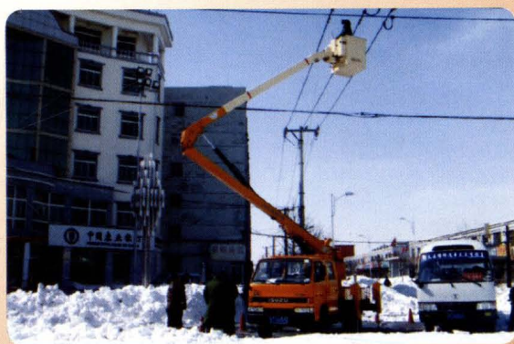
▲ 顶风冒雪维修配电线路 (2007.3.5)
