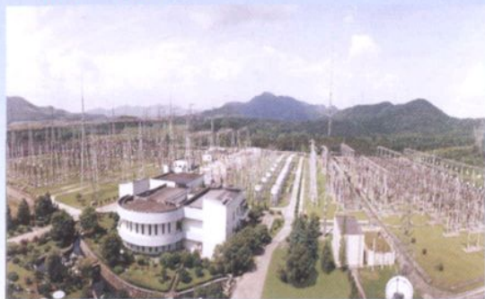
500 千伏兰亭变电所
