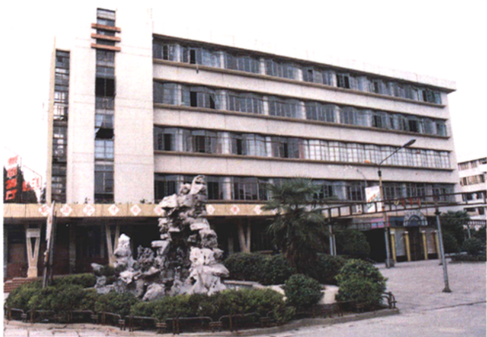
盐城市工会教学文化活动综合楼
