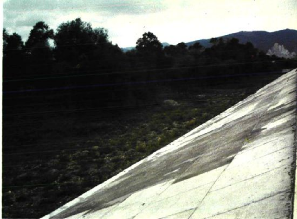
▲ 浑江桓仁镇堤防
