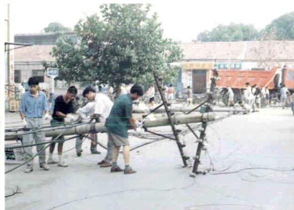
▲机线员们冒着高温抢修被汽车挂倒的市话线路
