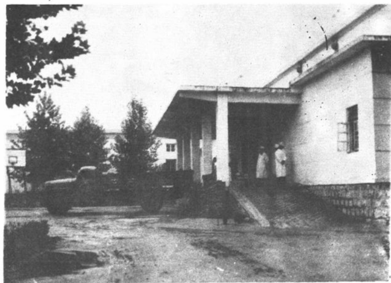
马尚冷藏厂冷库
