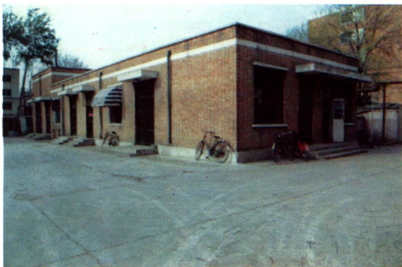
北辰区局油机房和配电室
