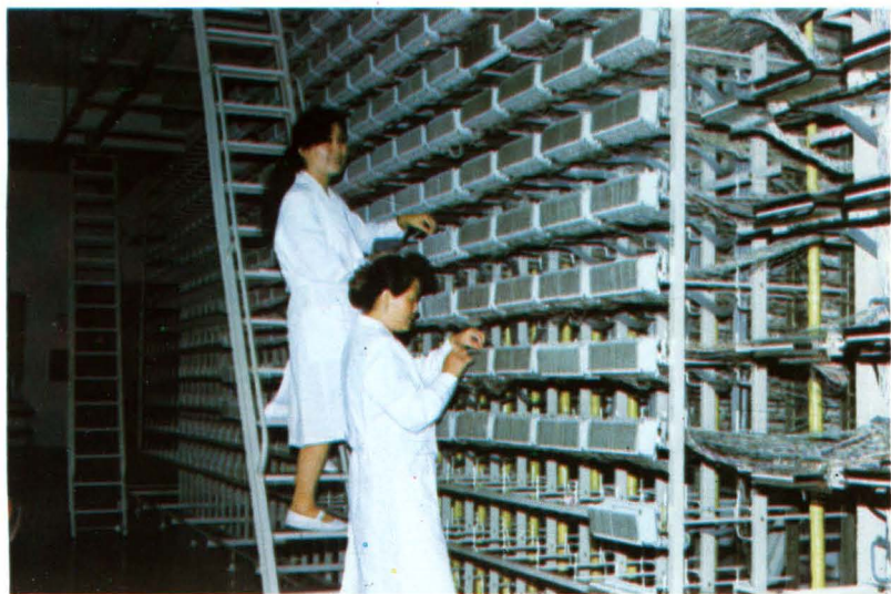
测量人员正在装机放号
