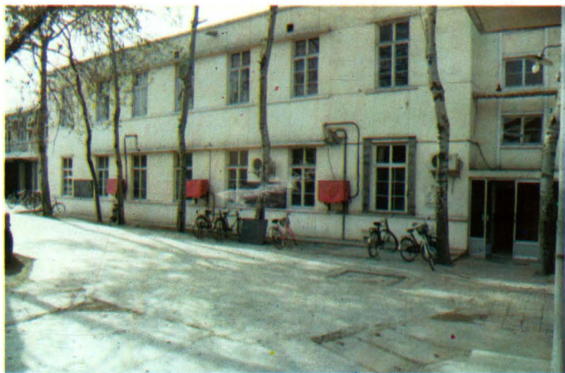
区局原步进制交换机楼房
