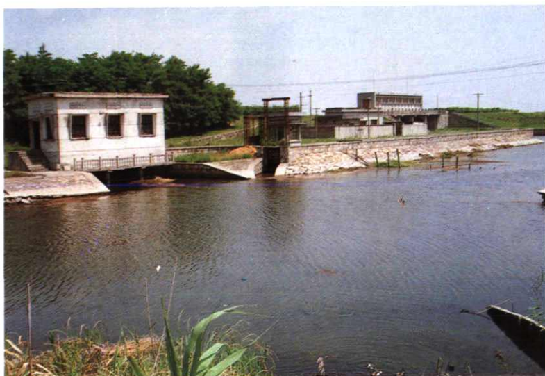
西大堤一号闸冲淤泵站
