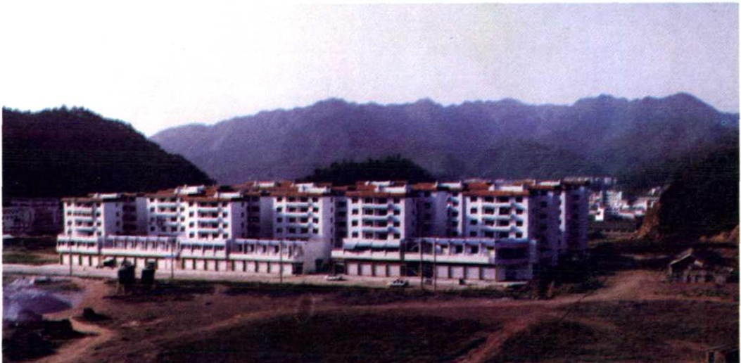
1995年底劈山填沟建成的桥南新屯住宅区
