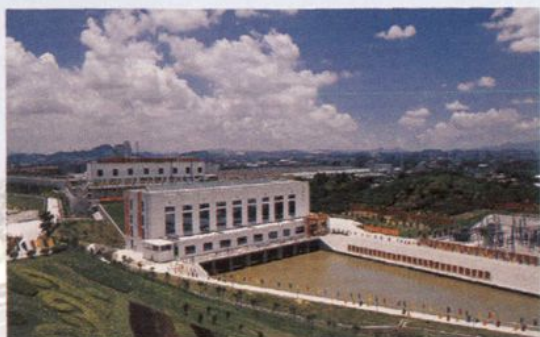
东深供水金湖泵站
