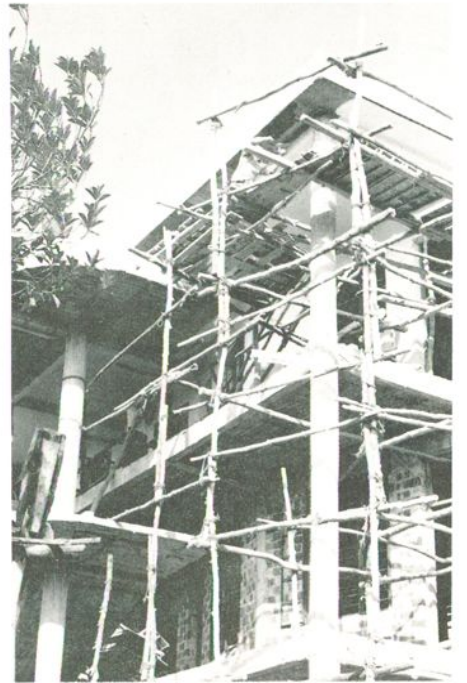
▼ 场建筑公司承建的楼房工程
