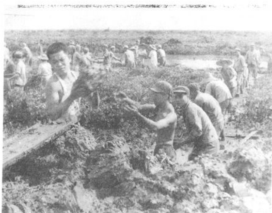
农场职工在三江围海造田工地上用滑板运泥
