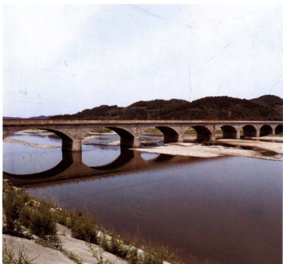
上夹河镇古楼大桥
