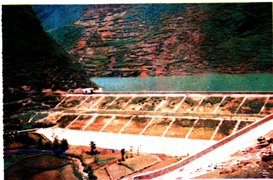
关岭县蚂蝗田水库
