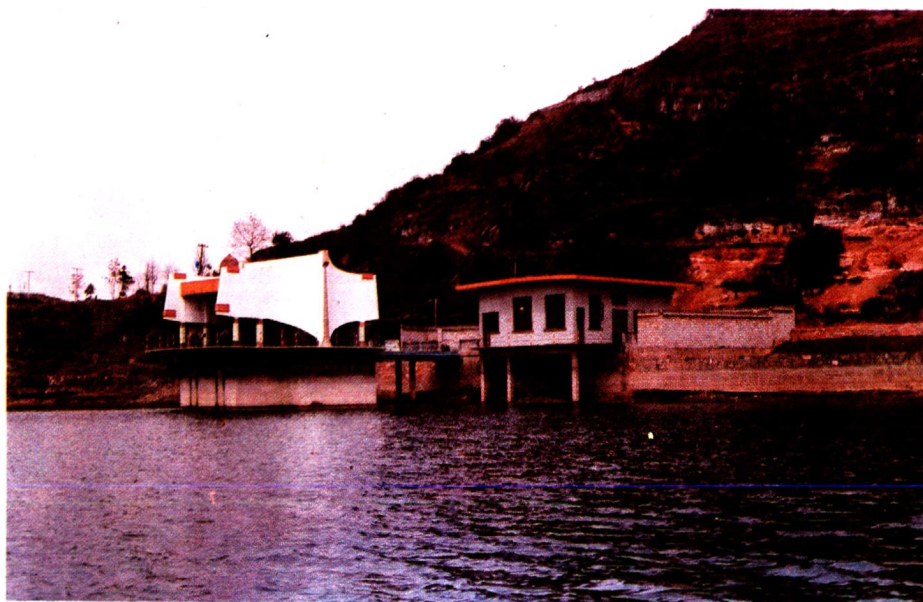
安顺地区猫猫洞水库取水泵房
