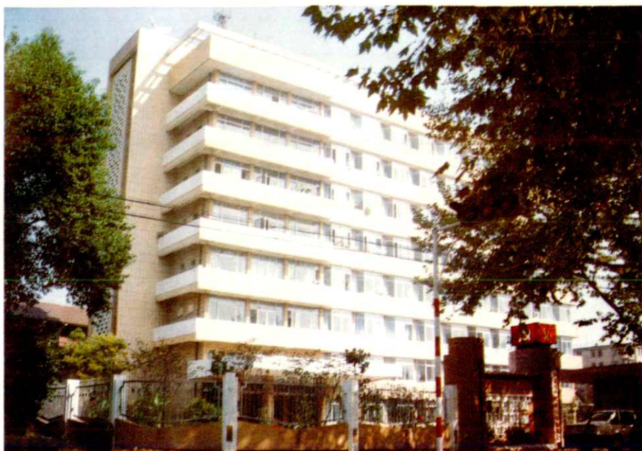
中共黄石市委办公大楼
