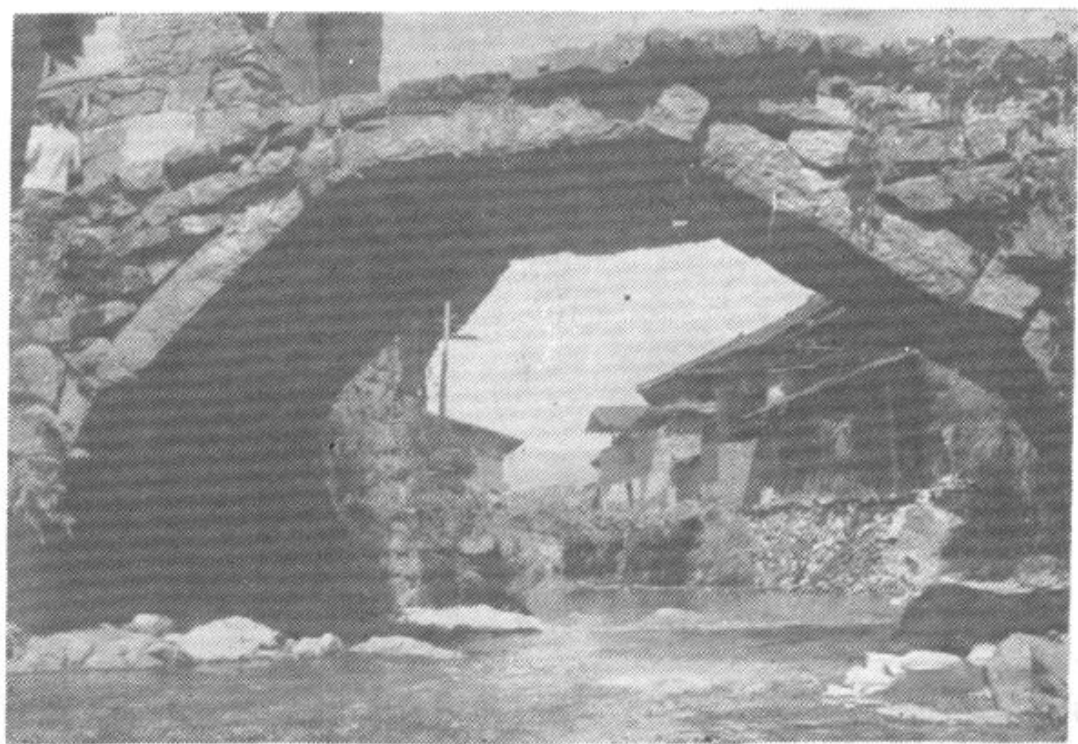
南阳村桥底——五角石拱桥
