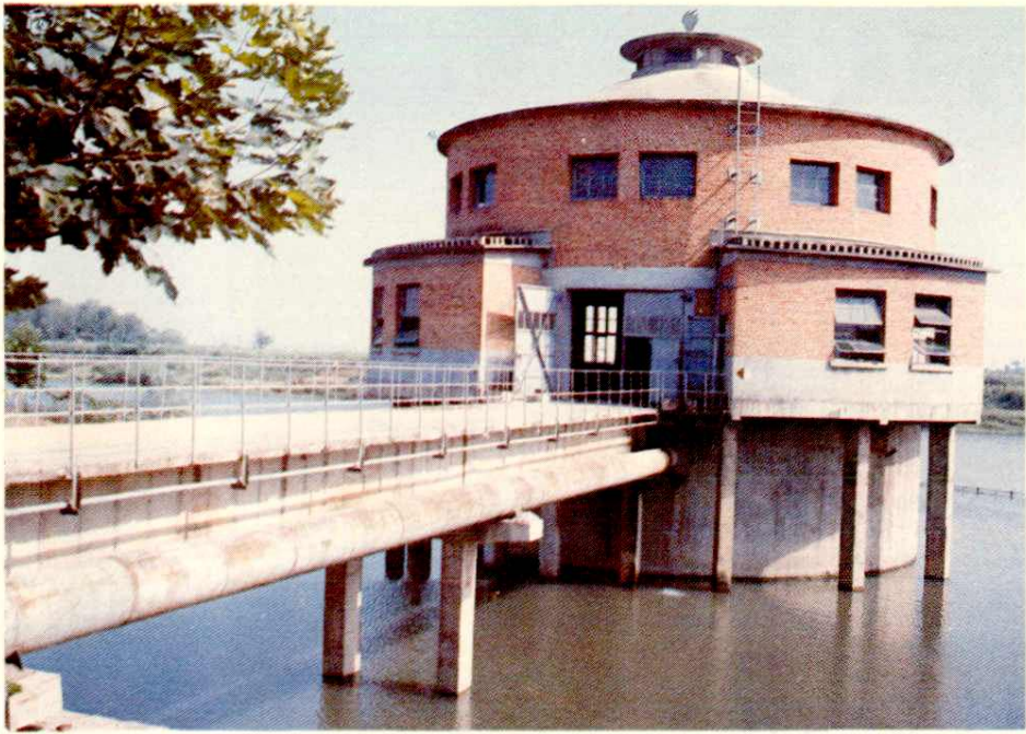
新一水 泵站泵房
