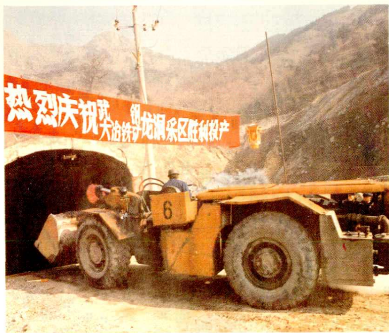
铲运机开进龙洞采区
