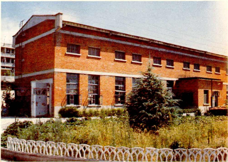
建设在鄂州的新二水 泵站
