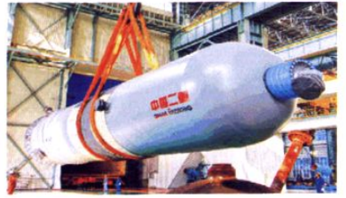
二重生产的最大吨位加氢反应器（重达460吨）——上海金山石化加氢反应器在重容分厂吊装
