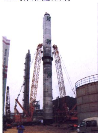
蓝星机械制造的国内首套年产15万吨DN4600硝酸吸收塔
