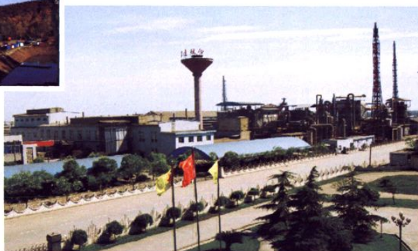
宏达集团德阳有色金属生产基地
