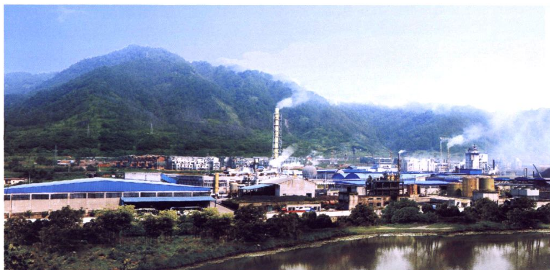
“5·12”汶川特大地震后， 菱峰实业恢复生产的穿心店生产基地
