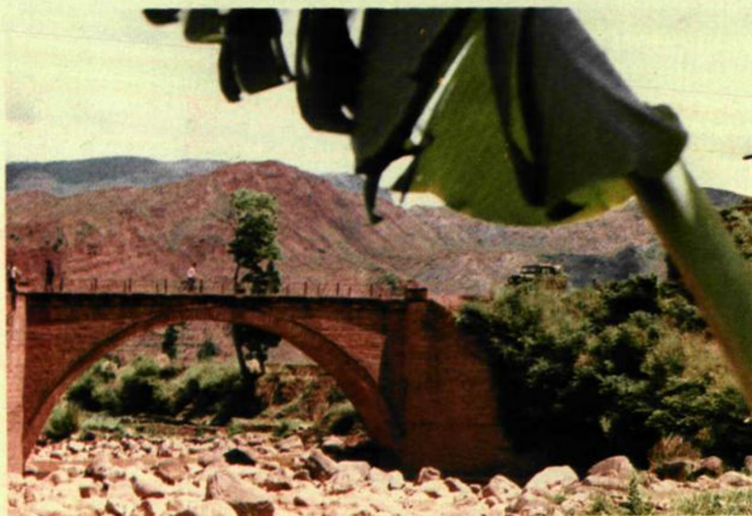
永济桥（又名十街小河桥）始建于清乾隆年间 民国二十年（1931年）重建、1975年改建成公路桥。
