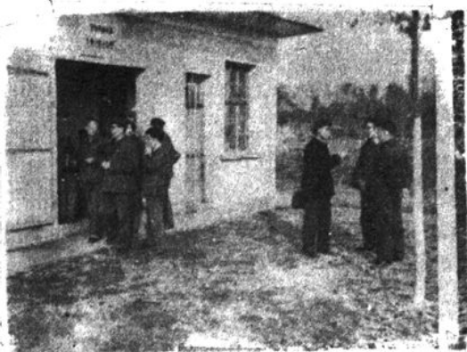
南方八省市代表视察无害化粪池
