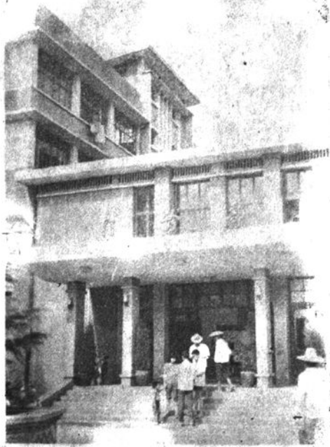
汉寿县人民医院门诊部
