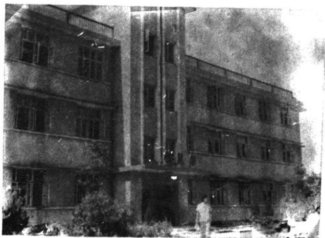
汉寿县中医院住院部
