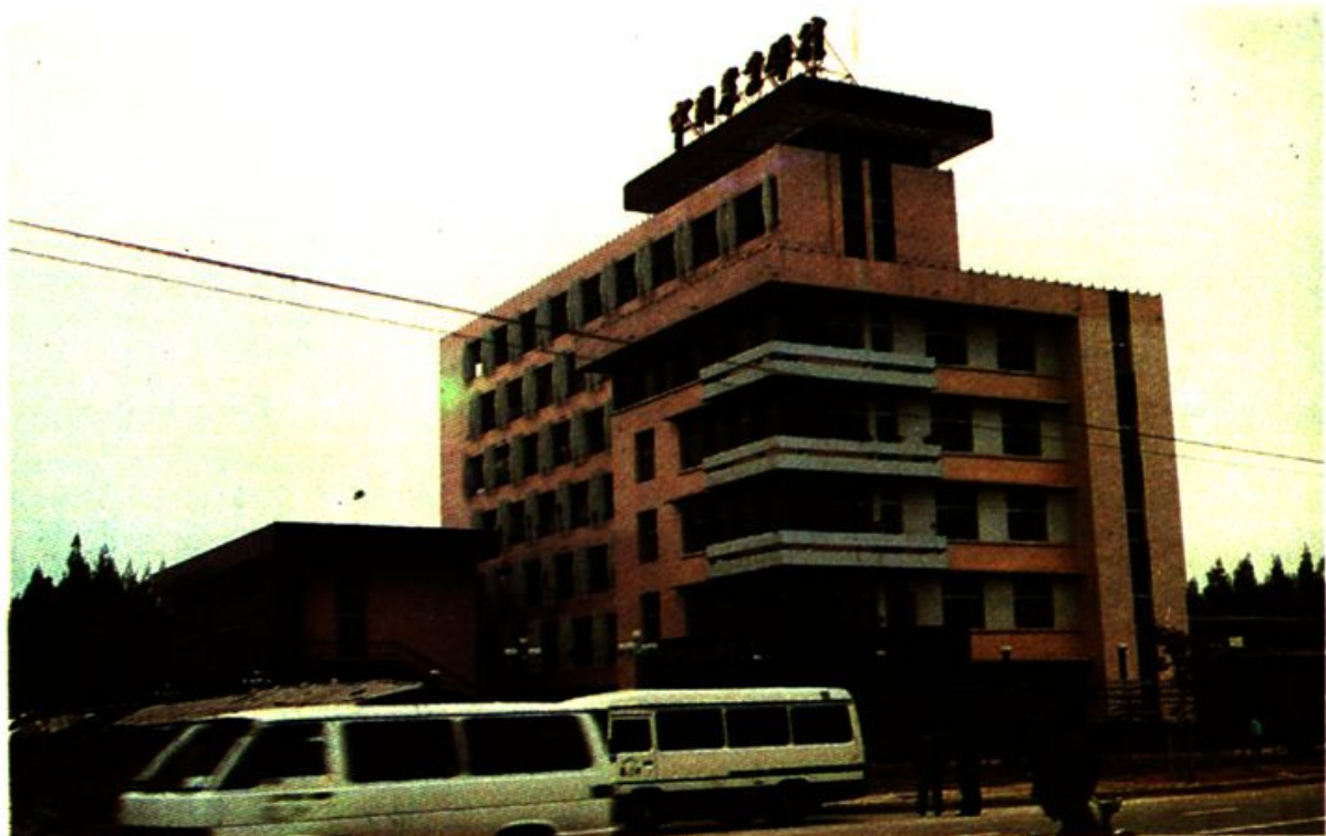
中国农业银行厦门市分行办公大楼。
