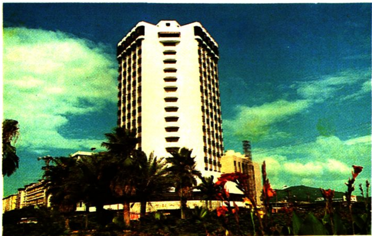
中国人民银行厦门分行办公大楼。
