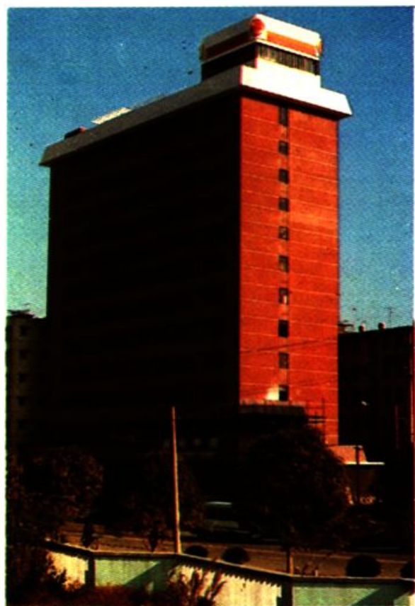
中国人民建设银行厦门市分行办公大楼。
