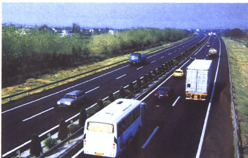
2002年10月，乍嘉 苏高速公路（海盐段） 竣工通车
