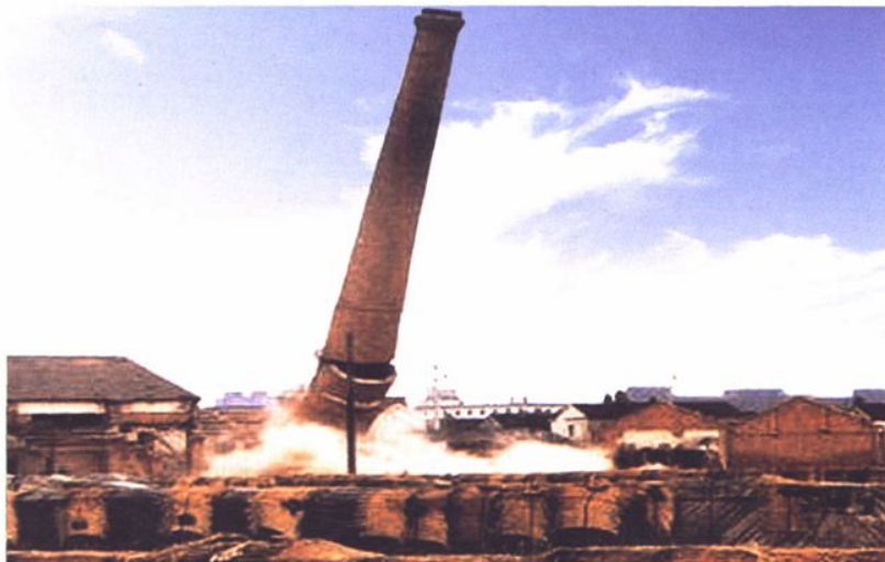
2000年起，海盐县全面展开建材行业整顿，至2002年全县34家轮窑厂关停21家，保留13家。图为富亨砖瓦厂烟囱爆破场景
