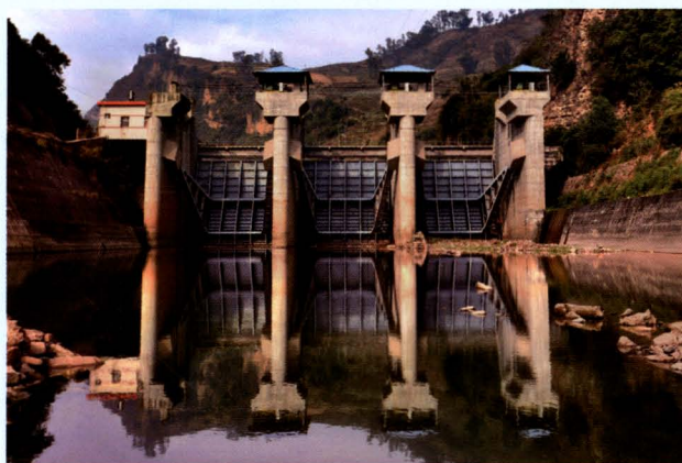
2012年10月27日，禄丰水电站竣工投入运行
