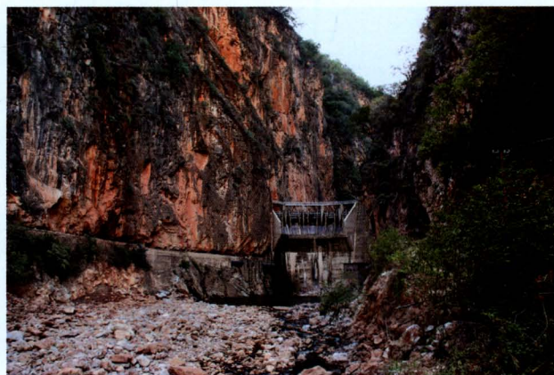
2009年10月，三佳电站竣工投入运行
