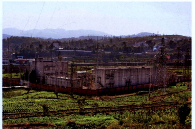
1995年5月31日，110千伏华宁变电站一期工程竣工投入运行
