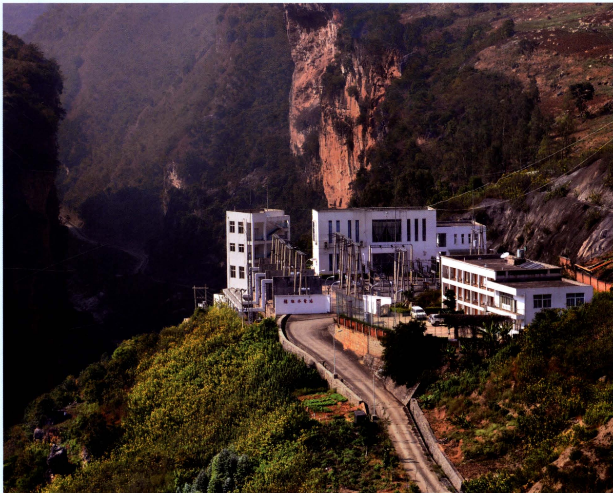
2008年8月8日，糯租水电站第一台机组竣工投入运行
