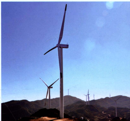
2013年12月11日，磨豆山风电场竣工投入运行
