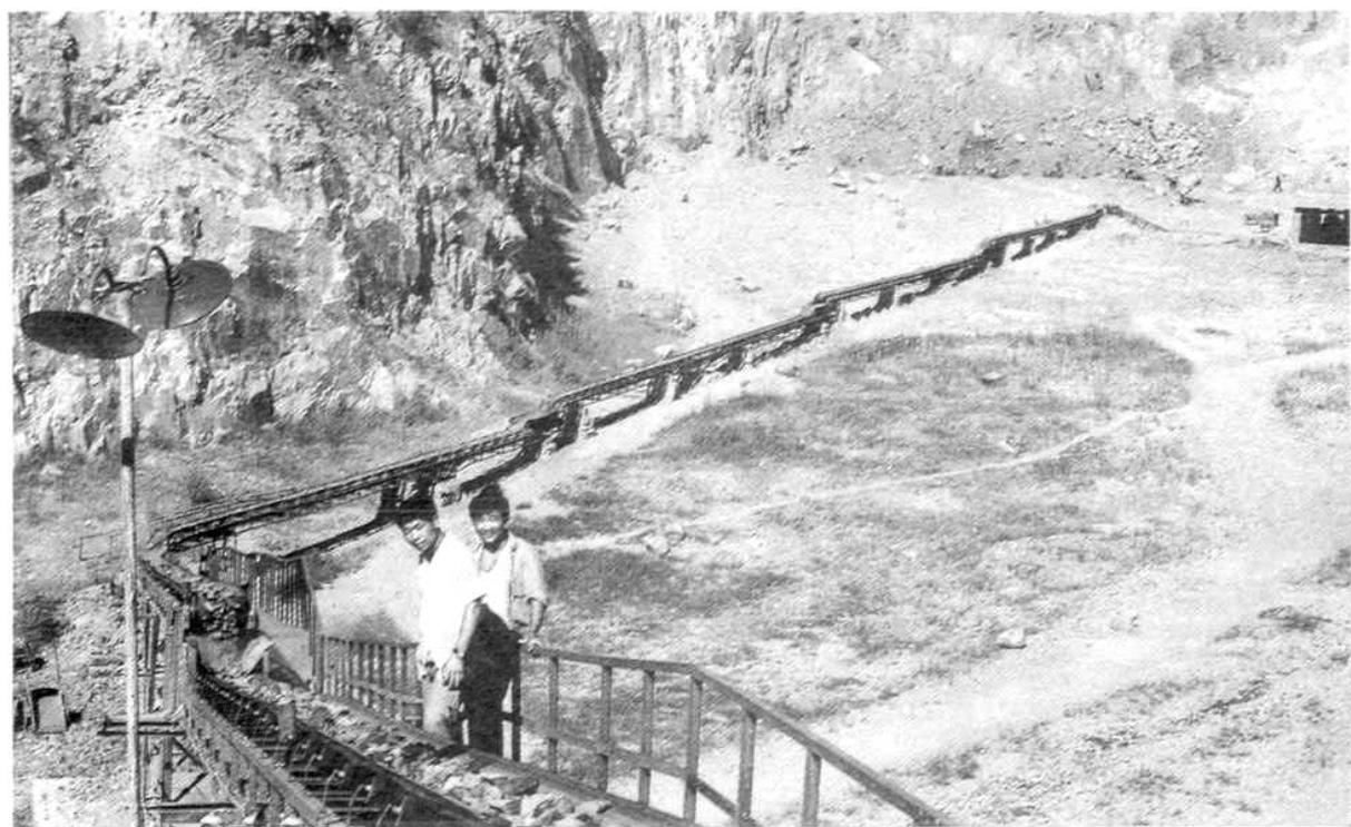
▲通元石料一厂 200余米长的输送线
