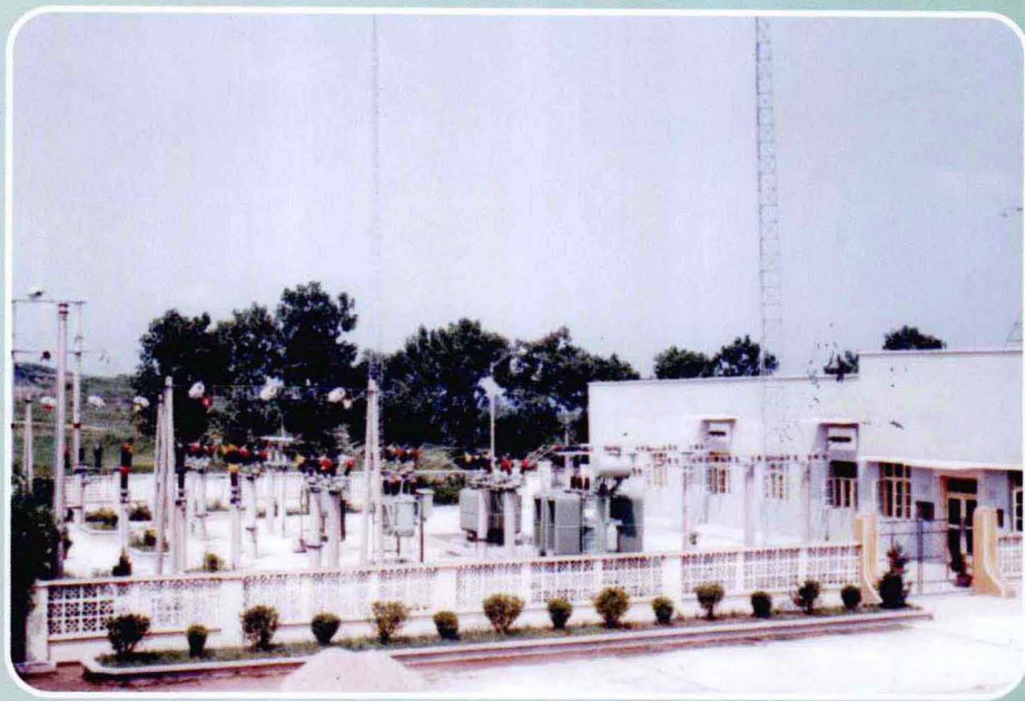
马良变电站（原姚集变电站）
