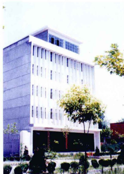
马良工业办公大楼(1987)
