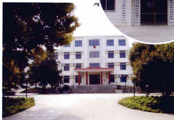
马良镇政府办公大楼
