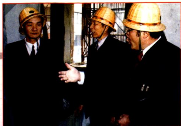
1996年，韶关市市长覃卫东（左一）视察韶关电力工业局变电站施工工地
