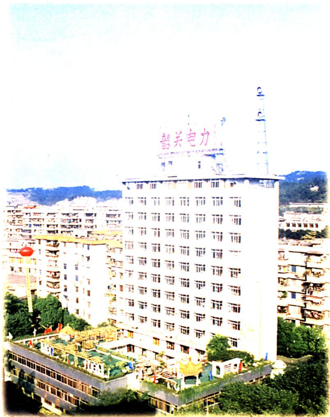
韶关电力工业局调度综合大楼
