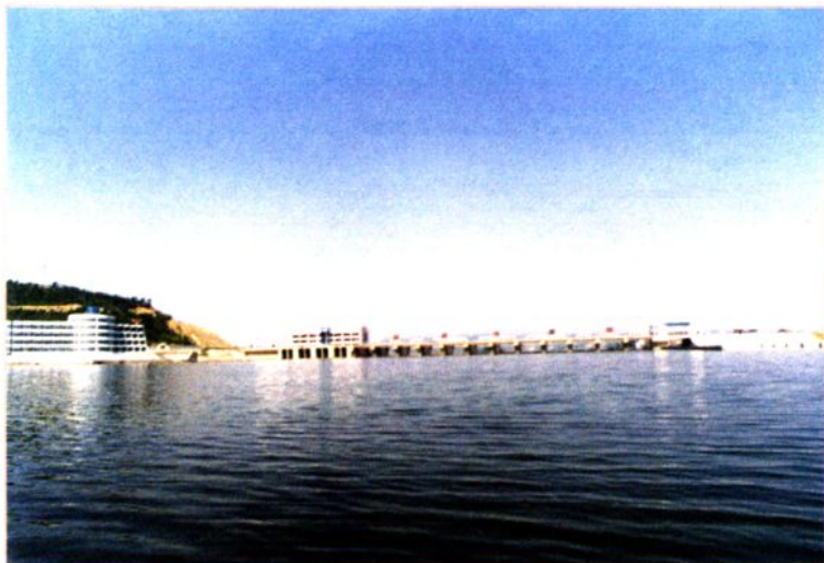
孟洲坝水电站总装机4× 1.2万千瓦（1998年建成）
