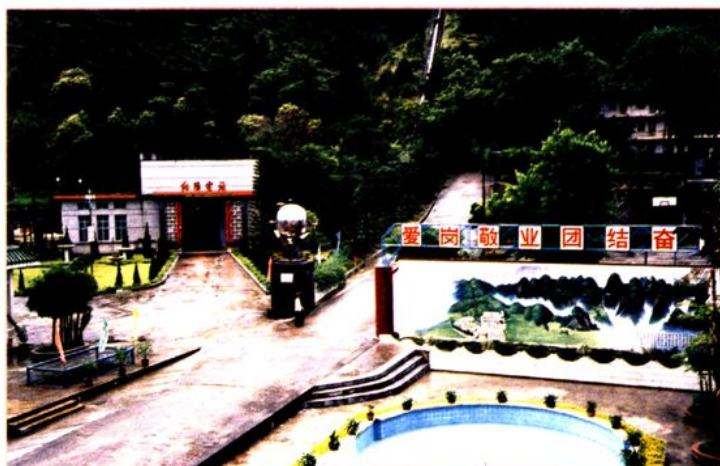
新丰县向阳电站，装机9000千瓦（1979年建成）
