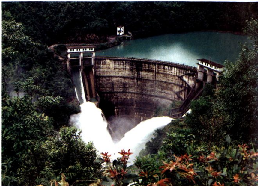
乳源泉水水电厂总装机 4×6000千瓦（1980年建成）
